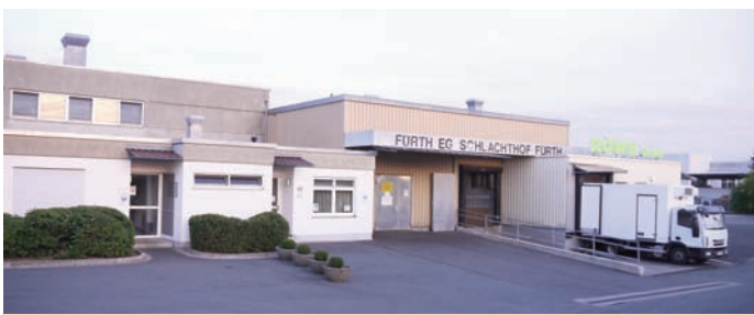
1990/91 gebaut: der Fürther Metzgerschlachthof an der Siegelsdorfer Straße 42 wird von 105 Gesellschaftern (Fleischer, Landwirte, Direktvermarkter, Lohnschlächter) getragen. Fotos: PR
